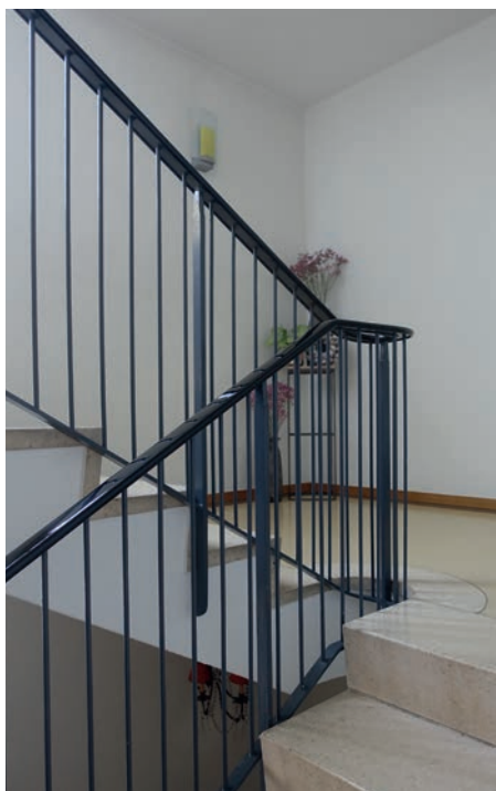
Klinik Hohmad: Treppenhaus 2023 (Foto Autor).
