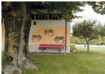
Transformatorenhaus 2018 (Foto: Markus Däppen).
