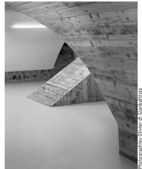
Nouvelle mezzanine intérieure.
