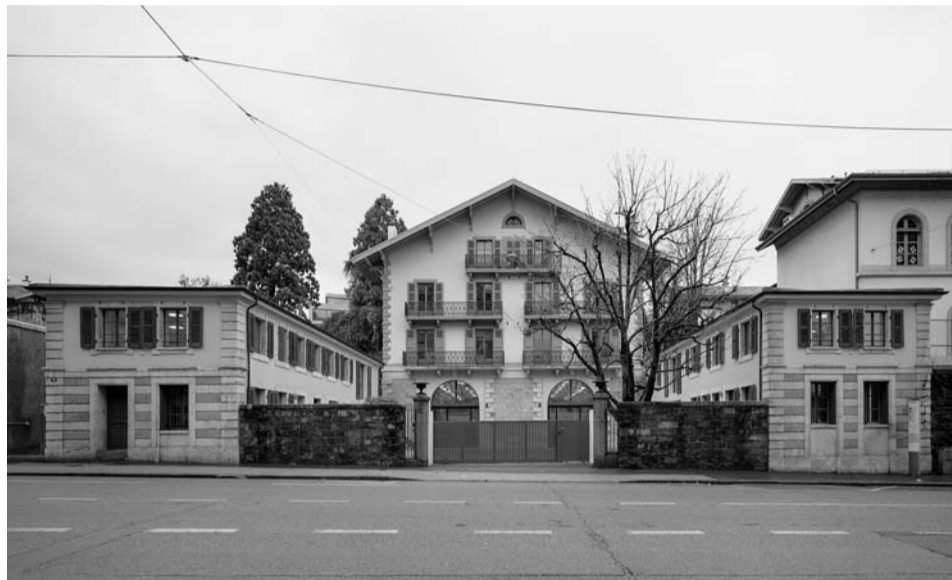
Vue actuelle depuis la route de Frontenex.
