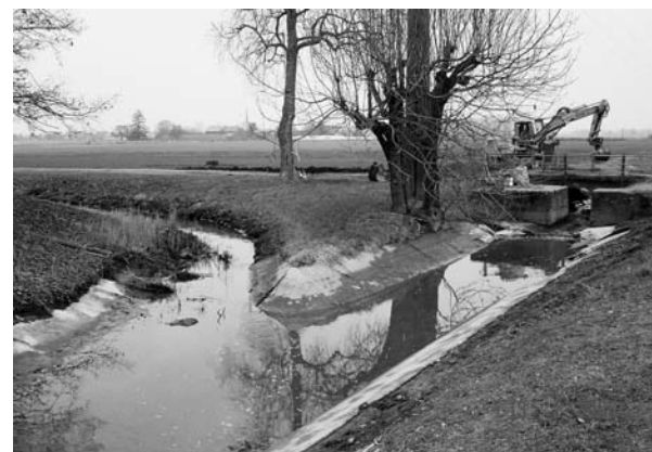
La Seymaz à Sionnet, avant et après les travaux de renaturation.
