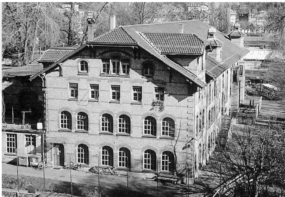
Dampfzentrale in Bern Foto: D. Wolf, Bern Centrale à vapeur, Berne Photo: D. Wolf, Berne
